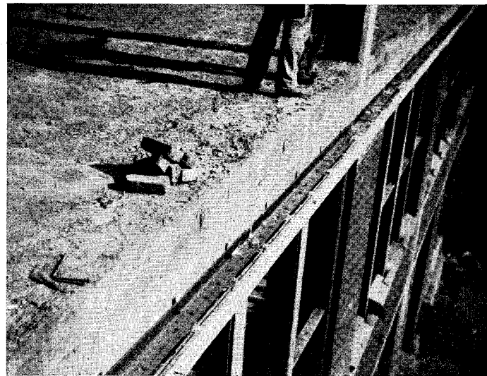
Fig. 268,1. Vinkeljern til Bæring af Skalmur.
