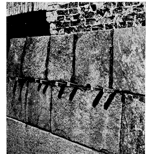
Fig. 255. Granitbeklædning af gammel Mur paa Christiansborg. Stenene i øverste Skifte staa paa Trækiler, og Fugerne er tættede med Værk. Mellem Granit og Teglstensmur hældes CM 1 : 2, der løber ud i Fugerne.
